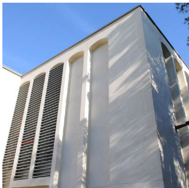
2 PARINTER RÉNOVATION utilisé sur béton
